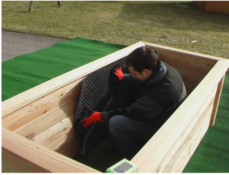
Anschließend verkleiden Sie das Hochbeet innen mit der beiliegenden Noppenfolie (Noppen zur Wand!). Nageln Sie die Folie mehrere Male mit den Breitkopfnägeln an. Wenn die Folie aus mehreren Teilen besteht überlappen Sie diese ca. 5 cm. Falls die Folie einen glatten Streifen hat, verwenden Sie bitte diesen unten bei dem Fundamentrahmen.
