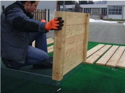
Stecken Sie die fertigen kurzen Seitenteile auf den Fundamentrahmen und verschrauben Sie die längeren Wandbretter mit den Ecksäulen.
