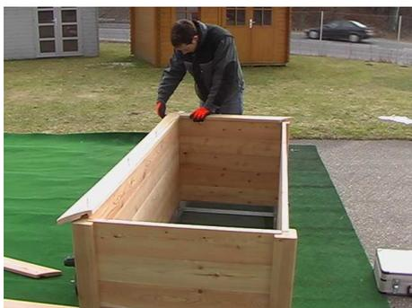
Nachdem Sie alle Seitenteile zusammengeschraubt haben, montieren Sie den Handlauf. Stecken Sie die Fräsung des Handlaufs auf das obere Brett und schrauben Sie diesen an den vorgebohrten Stellen mit den beiliegenden Edelstahlschrauben 4,5x70mm auf die Wandbretter und Ecksäulen.
