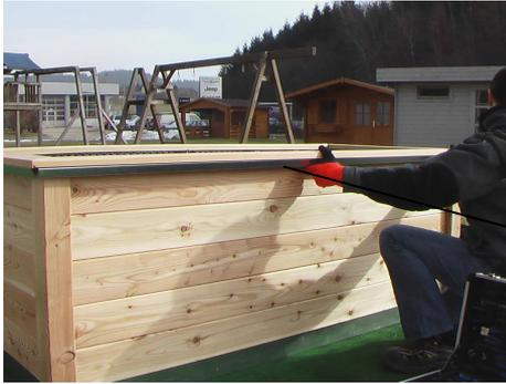
Wenn Sie sich für die optionale Schneckenkante entschieden haben, dann schrauben Sie diese mit den Schrauben 4,2x16mm unten am Handlauf fest.
