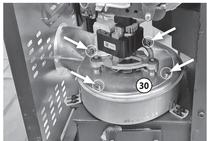
Achten Sie bitte darauf, beim Herausnehmen des **Abgasventilators (30)** Anschlusskabel und Flügelrad nicht zu beschädigen!
