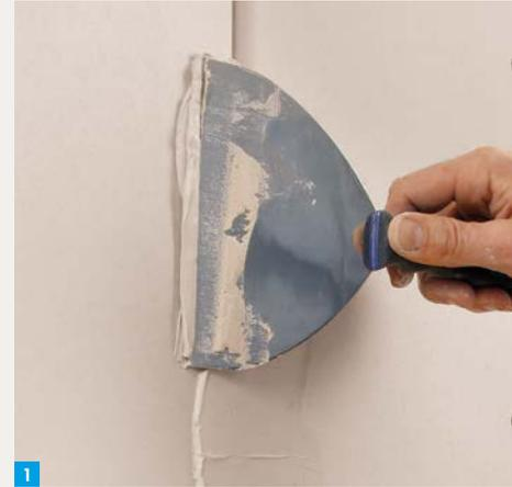
1. Knauf Uniflott in die Gipsplattenfuge einbringen.
