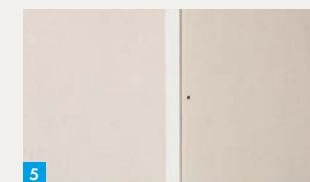
5. Gipsplatten mit ca. 5 mm Abstand montieren
