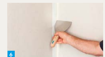
6. Fuge mit Uniflott verspachteln
