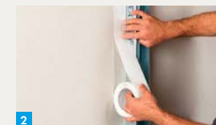
2. Trenn-Fix neben Profil kleben
