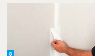
8. Überstehenden Streifen abziehen
