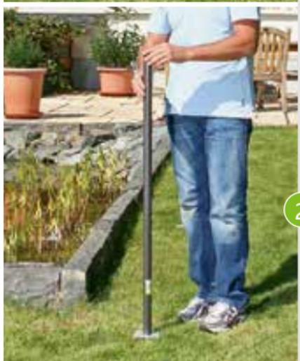
Wichtig: mit dem Einschlagwerkzeug arbeiten, da sonst die Bodenhülse beschädigt wird. Wird der Pfosten betoniert, werden min. 3 Säcke à 40 kg Beton pro Pfosten benötigt.
