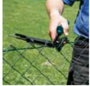
Sollten Sie die Drahtbefestigungszange nicht zur Hand haben, befestigen Sie den Maschendraht mit kurzen Stücken Bindedraht (Art.-Nr. 530150) am Spanndraht.
