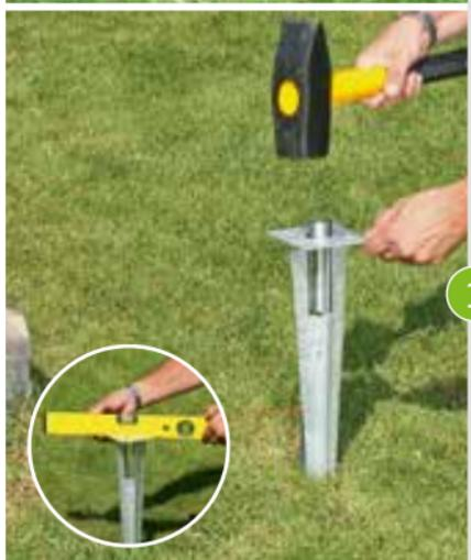
Info: Zur Kontrolle der korrekten Pfostenabstände sollte das Tor vor dem Einbetonieren komplett montiert werden.
