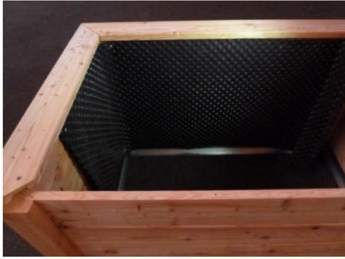
Anschließend verkleiden Sie das Hochbeet innen mit der beiliegenden Wandschutzfolie (Noppen zur Wand!). Nageln Sie die Folie mehrere Male mit den Breitkopfnägeln an. Da die Folie aus mehreren Teilen besteht überlappen Sie diese mind. 5 cm. Falls die Folie einen glatten Randstreifen hat, verwenden Sie bitte diesen unten beim Fundamentrahmen.
