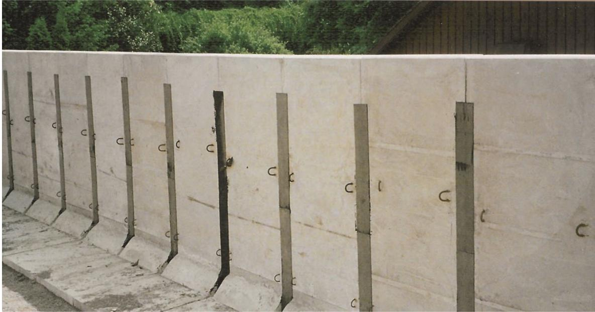
7. Galabeton Winkelstützen sind mit einem nichtbindigen Material (Füllsand) zu hinterfüllen. Der Füllboden ist lagenweise einzubringen und zu verdichten (Schütthöhe ca. 30 cm). Die Verdichtungsgeräte müssen mindestens 1/3 der Mauerhöhe bzw. 50 cm Abstand zur Rückseite halten. Ein Verdichtungs-erddruck darf sich nicht aufstauen!
