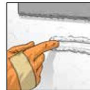
**3.** ERFURT-KlimaTec System-Kleber satt mit einer langflorigen Walze bahnenweise (siehe Fingertest) auf alle glatt bis mittel strukturierten Untergründe aufrollen.
