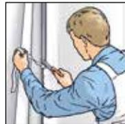
**5.** Überstehende Außenecken mit einem Cuttermesser oder einer Hakenklinge sauber abschneiden. Zur optischen Stabilisierung der Außenecken, empfiehlt sich das Anbringen von Kunststoffeckleisten auf das ERFURT-KlimaTec Thermovlies.
