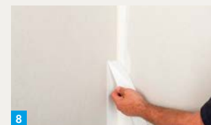
8. Überstehenden Streifen abziehen
