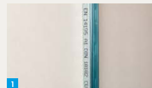
1. Profil auf angrenzendes Bauteil montieren
