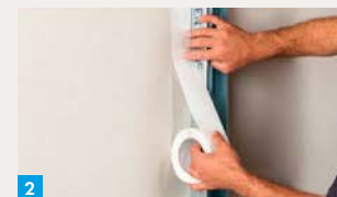
2. Trenn-Fix neben Profil kleben
