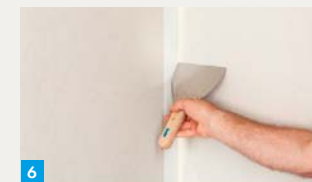
6. Fuge mit Uniflott verspachteln
