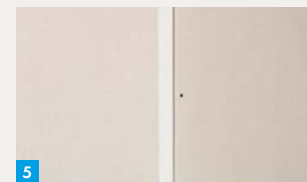
5. Gipsplatten mit ca. 5 mm Abstand montieren
