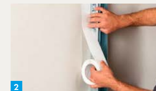
2. Trenn-Fix neben Profil kleben
