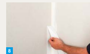
8. Überstehenden Streifen abziehen
