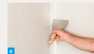
6. Fuge mit Uniflott verspachteln
