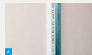
4. Trenn-Fix andrücken und glatt streichen
