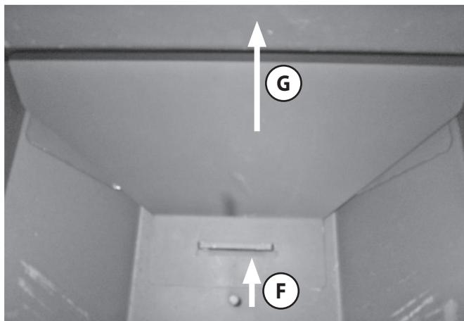
Darüber befindet sich eine vierte Rauchgasumlenkung aus Blech. .
