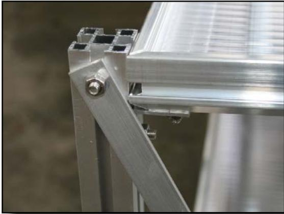
Um die kurzen Querstreben zu montieren, schieben Sie eine Schraube M6 x 12 in den Schraubkanal der Design-Sprosse.
