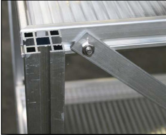
Stecken Sie die lange Querstrebe auf die Sechskantschraube M6 x 12.
