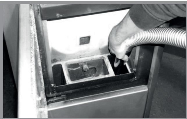
Abb. 12g: Reinigung untere Brennkammer
