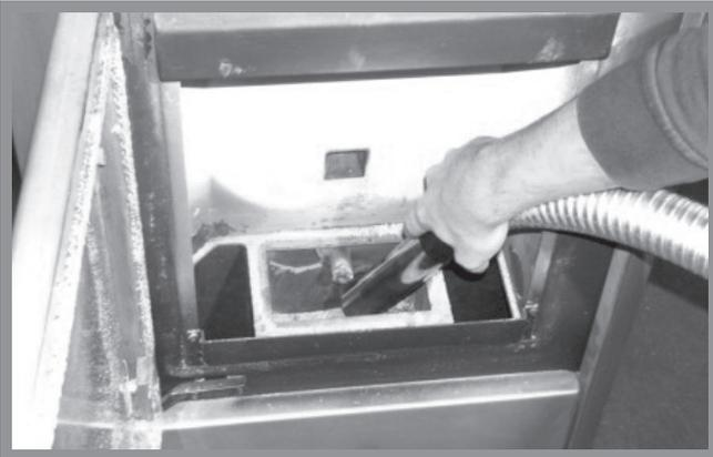
Abb. 12f: Reinigung Brennraumbehälter
