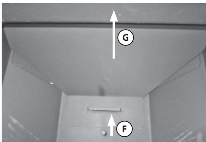
Darüber befindet sich eine vierte Heizgasumlenkung aus Blech.
