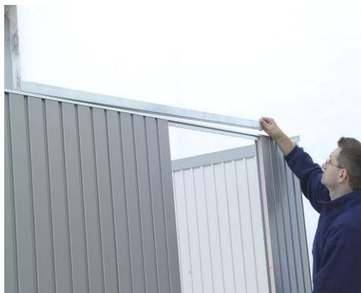
**3.** Bevor Sie mit Punkt 5 der Gesamtaufbauanleitung fortfahren, setzen Sie das Versteifungsprofil über die Aussparung „Zusatztür“.
