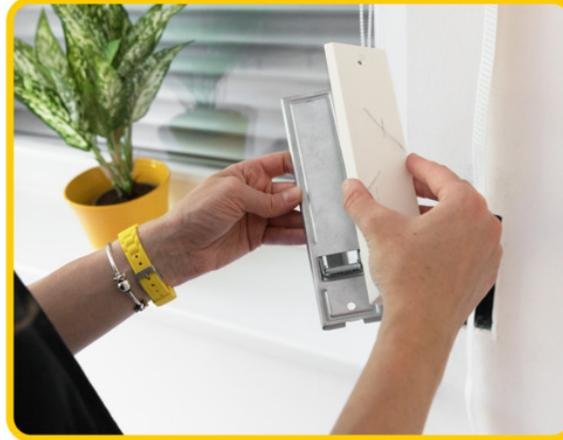
Den Einlasswickler ausbauen, den Rollladengurt abwickeln, von der Trommel trennen und die alte Abdeckplatte entfernen (falls vorhanden).
