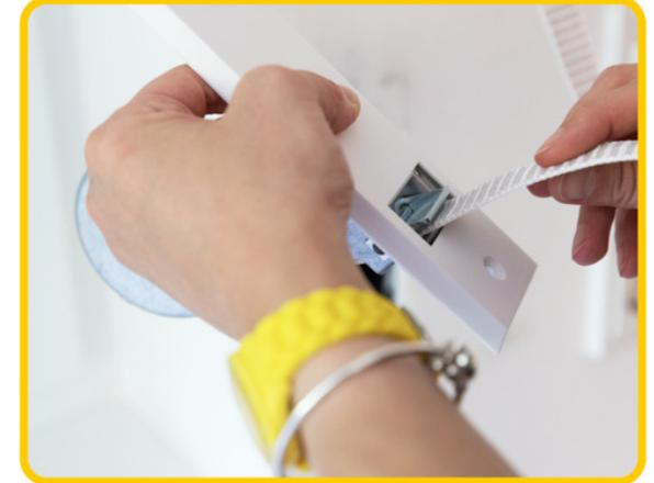
Die neue Abdeckplatte auf dem Wickler platzieren, den Rollladengurt durchfädeln und auf der Trommel befestigen.
