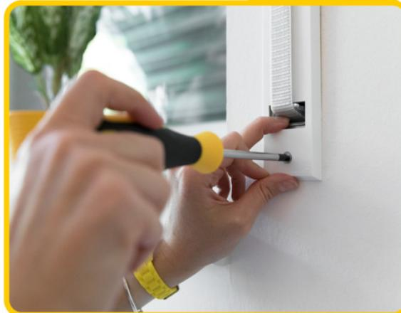
Die Wickeleinheit wieder in den Mauerkasten einsetzen und anschrauben.
