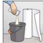
**3.** Zur Verklebung wird Vlieskleber verwendet.
