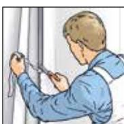
**9.** An Außenecken wird nicht überlappend tapeziert. Hier erfolgt die Trennung exakt auf der Kante.
