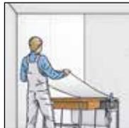
**4b.** Einkleistern per Kleistergerät: Bahnen durch das Kleistergerät ziehen und abschneiden. Rapport beachten.
