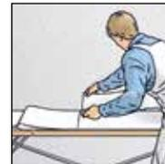
**5.** Die eingekleisterten Bahnen werden 2/3 zu 1/3 zusammengelegt. Schlaufen nicht knicken.
